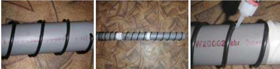
Наматываем провода метра три (лишние потом отрежем), после, вытягиваем спираль вдоль трубы, так чтоб витки ложились по меткам и временно крепим их изолянтной или малярным скотчем... клеим витки суперклеем... последние пару витков оставляем держатся на изолянте.
