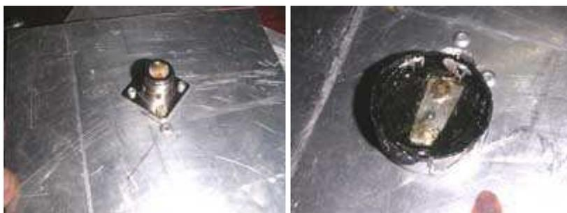
Заливаем стакан силиконовым клеем, для большей механической прочности крепления трубы... и на этом основание антенны готово.
